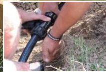
Verbindungen dichten
